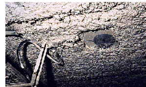
Flocage de plafond
