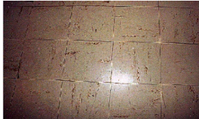
Dalles de sol
